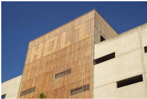
Das Holzheizkraftwerk ist ein wichtiger Baustein der klimafreundlichen Wärmeversorgung der SWLB
