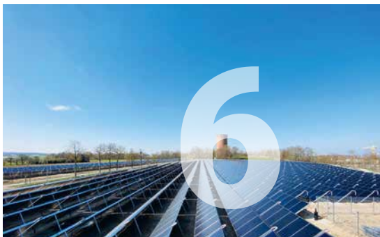
Die Solarthermieranlage speist klimafreundlich erzeugte Wärme in das Fernwärmenetz ein
