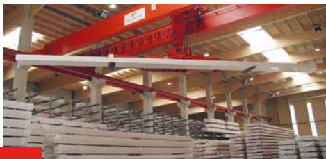
Automatisierte Krananlagen von Voith Kran Austria übernehmen Lager- und Materialflüsse
