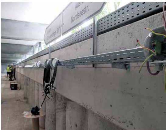
Durchgeführte Betoninstandsetzung an einem Parkhaus der Dr. Ing. h.c. F. Porsche AG – ein Beispiel für die spezialisierten Sanierungslösungen der Consolvo GmbH
