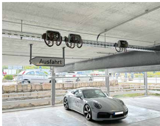
Instandsetzung mit Wirkung: Bei einem Parkhaus der Dr. Ing. h.c. F. Porsche AG brachte Consolvo ihre Expertise in der Betonsanierung ein
