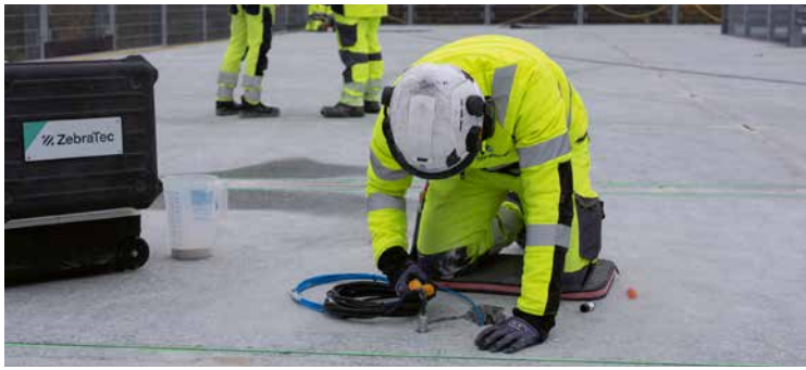
Auf der Baustelle der HWA in Affalterbach: Mitarbeiter von Consolvo bei der Installation eines Systems für den kathodischen Korrosionsschutz (KKS)
