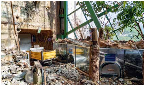
Bei Bauarbeiten zu einem...
