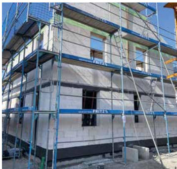
Regionale Handwerkspartner sorgen für eine zuverlässige Ausführung vom Rohbau bis zur Fertigstellung
