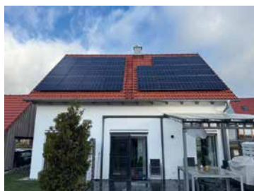
Bei Neubauten ist die Integration von Solaranlagen heute meist Standard
