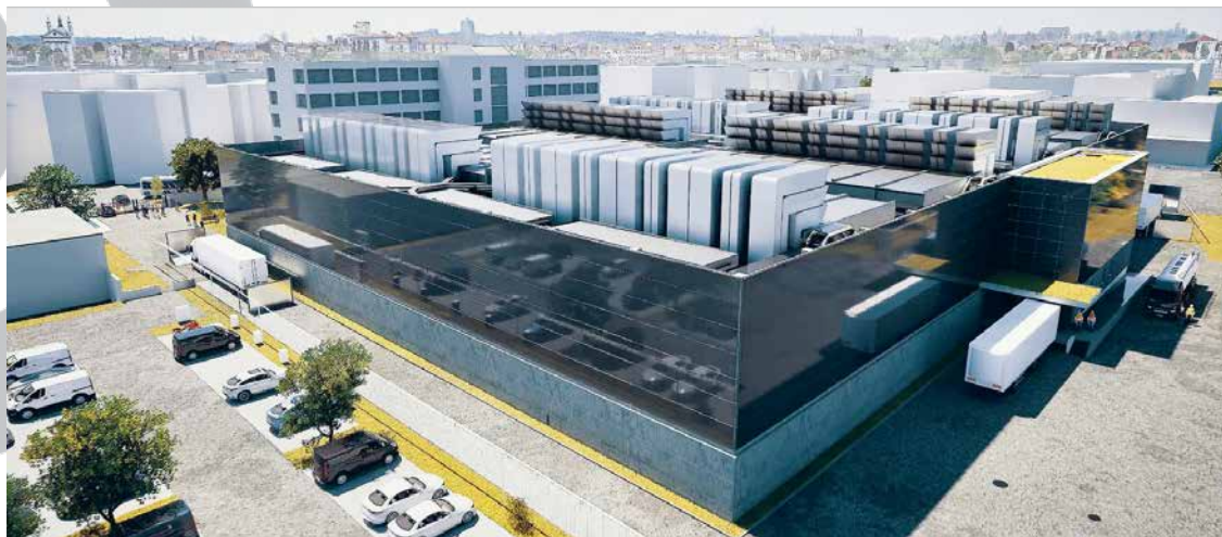
Aus vielen einzelnen Bausteinen entsteht das große Ganze – ein Rechenzentrum, das hohe Anforderungen an Sicherheit, Verfügbarkeit und Energieeffizienz erfüllt
