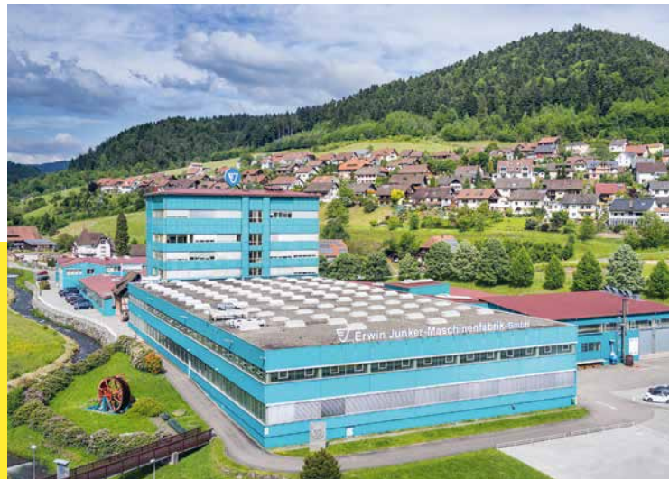
Am Hauptsitz der Erwin Junker Maschinenfabrik GmbH in Nordrach sind jahrzehntelange Engineering-Kompetenz und modernste Fertigungstechnologie vereint
