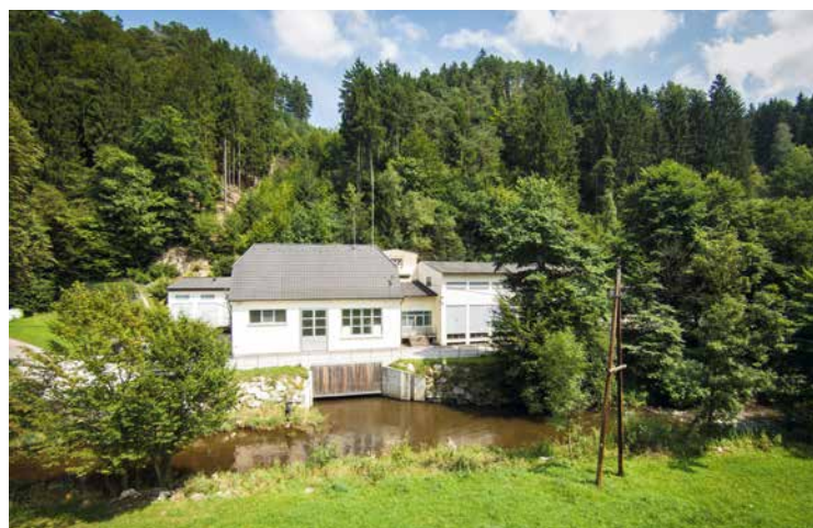
Seit über 100 Jahren Teil der regionalen Energieversorgung: Das Wasserkraftwerk Kegel-schmiede verbindet historische Substanz mit der Erzeugung erneuerbarer Energie
