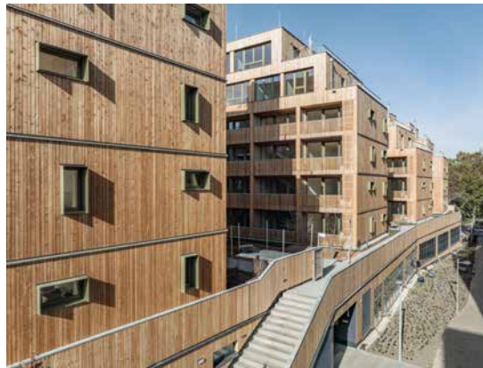
Das Woody-M Projekt in Wien steht für preisgekrönten Holzbau, hohe Vorfertigung und moderne, nachhaltige Architektur
