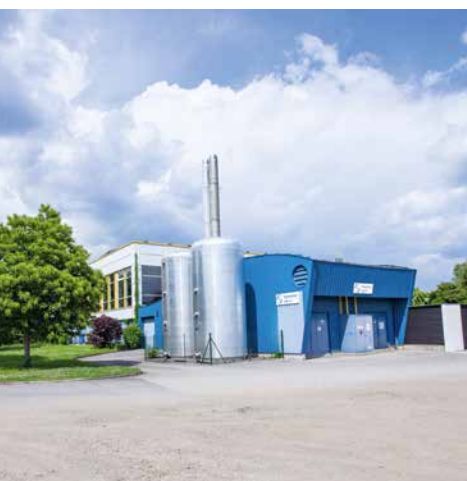
Das Blockheizkraftwerk des E-Werks Perg steht vor der nachhaltigen Transformation
