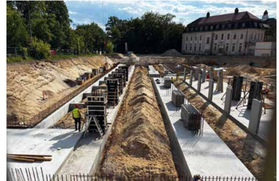
Neubauprojekt in Berlin während der Bauphase: Transparenz im Projektverlauf ist ein wesentlicher Bestandteil der Beratung
