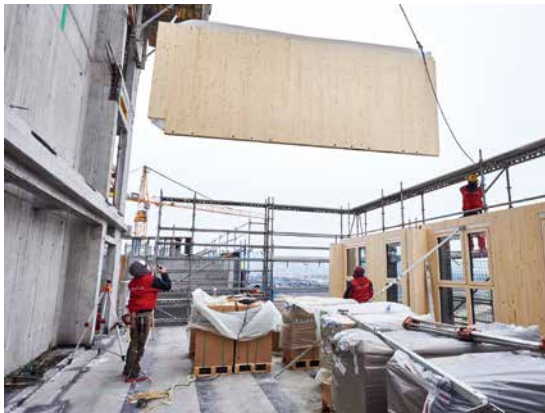
Vorgefertigte Wandelemente werden per Kran montiert – schnell, präzise und mit deutlich verkürzter Bauzeit
