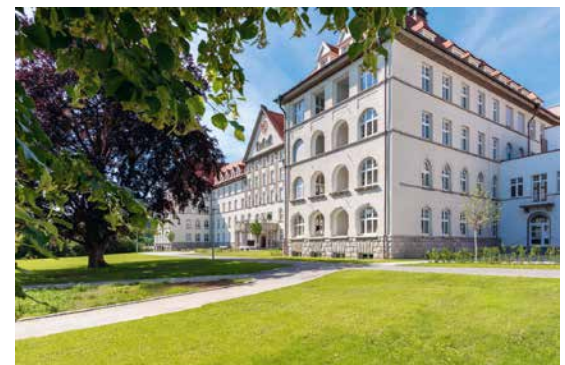
Historische Bausubstanz, modern gedacht: Denkmalsanierung in Ulm
