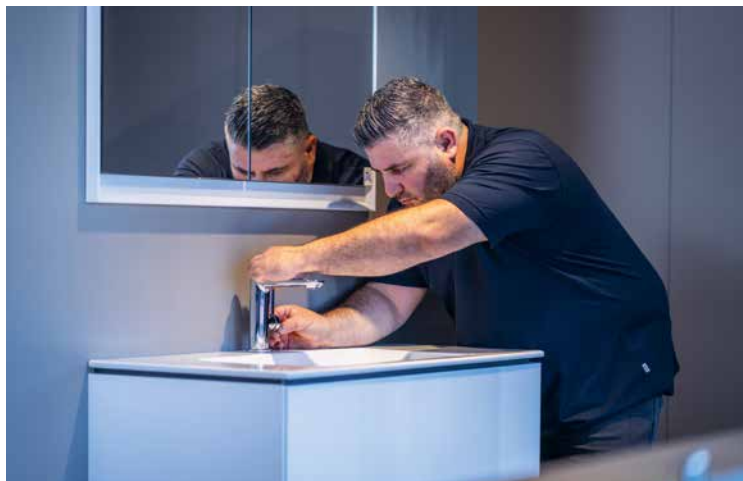
Montagearbeiten in den Showrooms der Kunden – wichtiges Element des Portfolios
