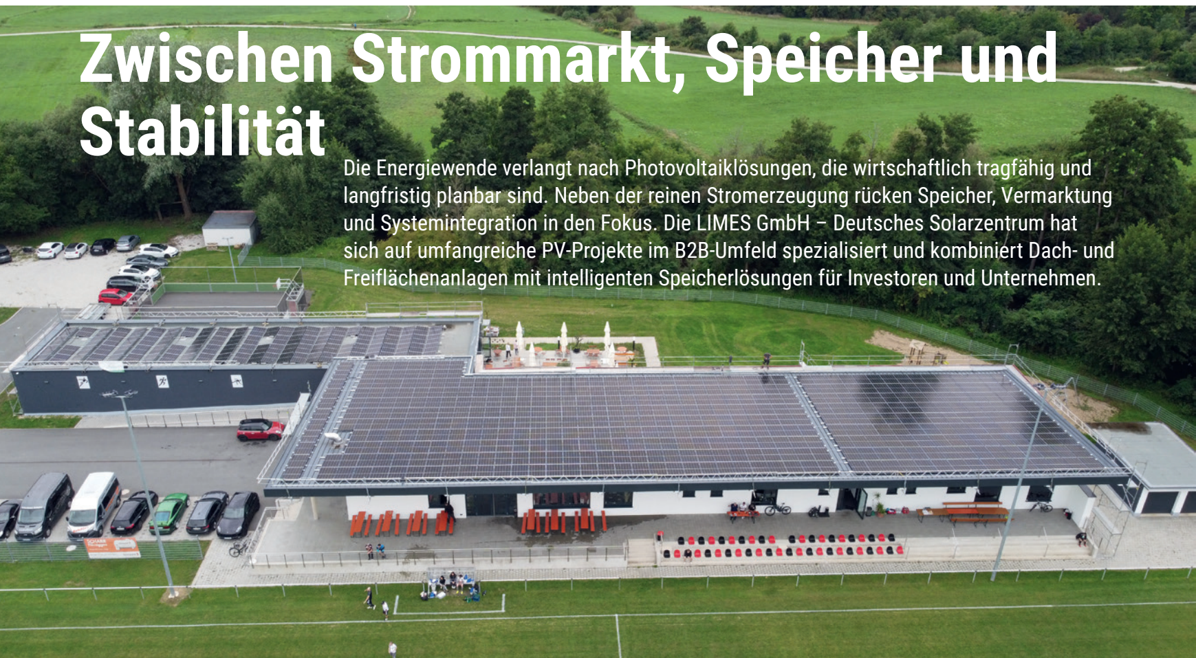
Die Photovoltaikanlage des ATSV Forchheim, Bayern mit 207,46 kWp ist ein Beispiel für das Dachpachtmodell von LIME: Der Verein verpachtet seine Dachfläche langfristig und erhält die Pacht vorab, während Planung, Bau und Betrieb der Anlage übernommen werden
