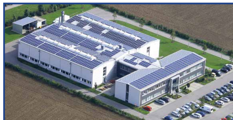
Nachhaltige Produktion: Preglers moderner Unternehmensstandort im niederbayrischen Deggendorf. Mit der Photovoltaikanlage auf dem Dach wird im Jahr mehr Strom produziert als verbraucht
