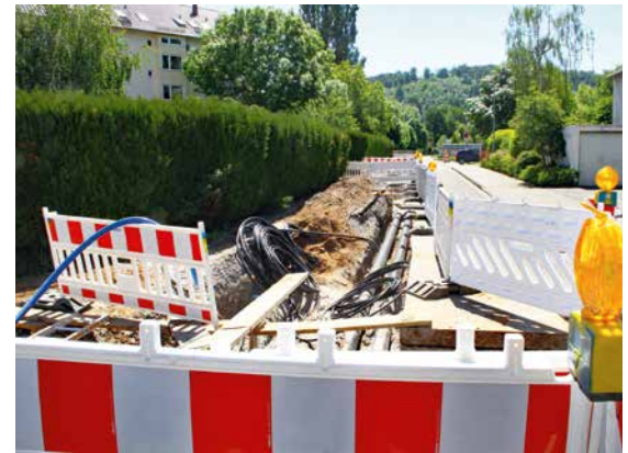
Idealerweise sollen sich die Bürger über Baustellen freuen – dadurch geht schließlich etwas voran
