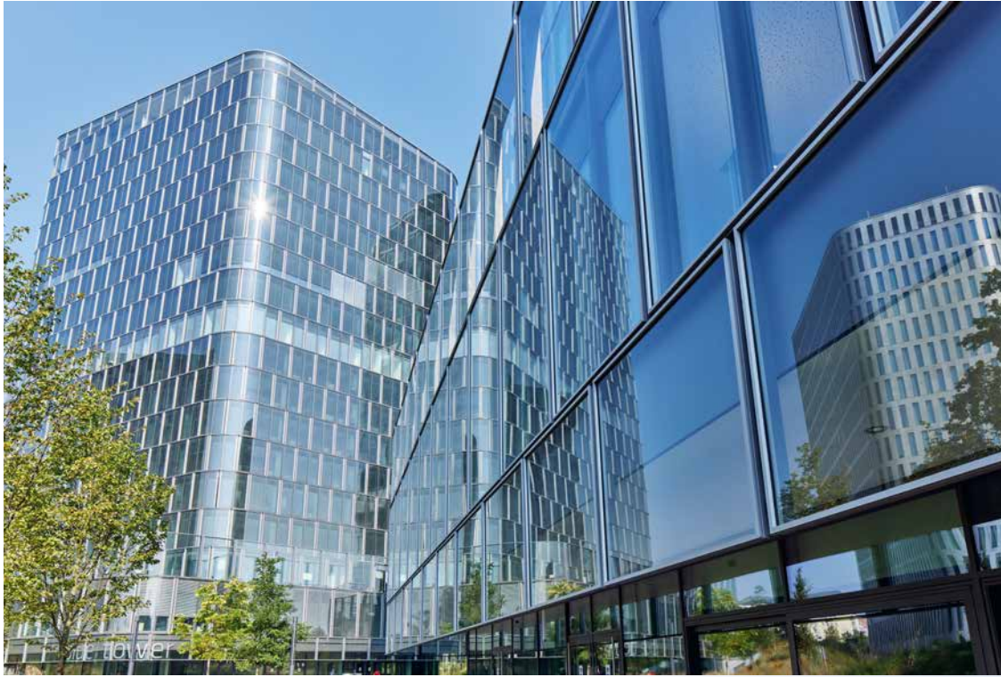
SAUTER übernimmt das Facility Management der Bavaria Towers in München und sorgt für effiziente Abläufe
