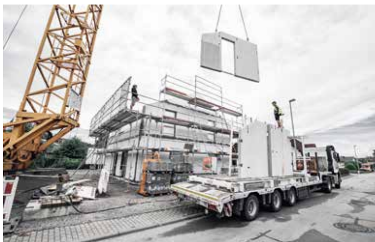
Über die Hauser Bauweise verringert sich die Bauzeit auf der Baustelle signifikant; hier ein Bauprojekt an der Hopfenstraße in Vöhringen
