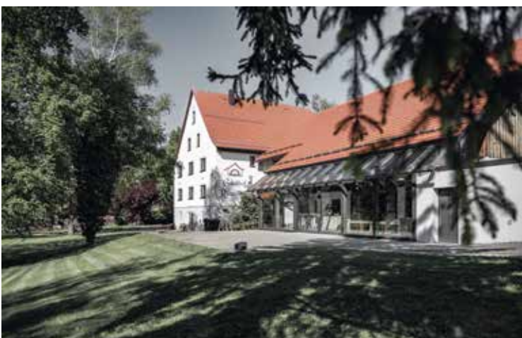
Ein Hauser Referenzprojekt an der Rötenuhle in Vöhringen
