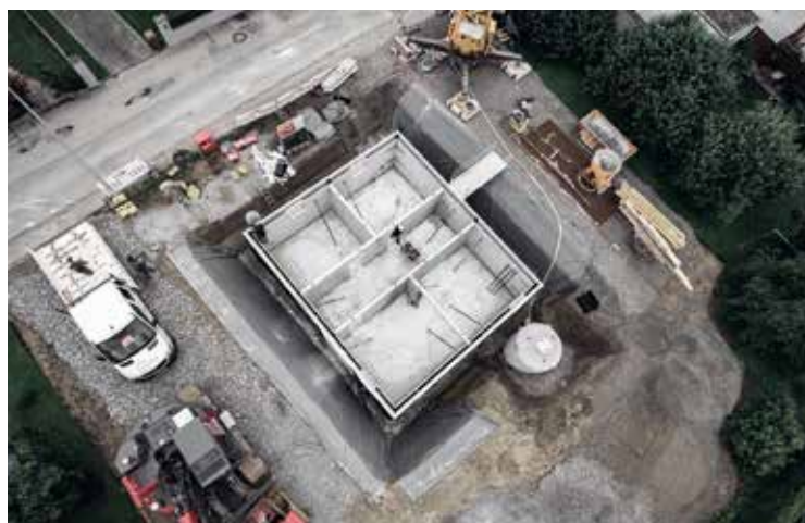
Hauser verbindet das Beste aus zwei Welten, aus der Holz- und der Massivbauweise
