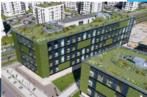
Dach- und Fassadenbegrünungen spielen bei neuen Projekten eine immer größere Rolle
