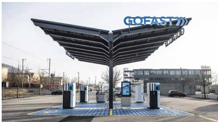
Mit Gofast hat Pletscher Metallbau ein Tankstellendach für Elektroautos entwickelt, mit Glas-Glas-Panels, die Strom produzieren
