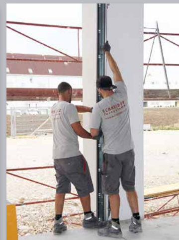
Zwei Mitarbeiter von Schneider Torsysteme bei der Installation eines Tors
