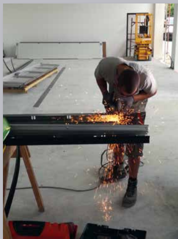
Die Installation der Tore erfordert viel Erfahrung und Präzision
