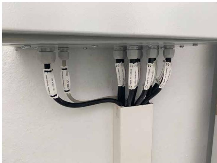
Das PARTEX Kennzeichnungssystem PPQ – das kundenindividuell von PARTEX bedruckt wird – trägt zum sicheren Betrieb von Schaltanlagen bei. Alle Komponenten sind dauerhaft und gut lesbar
