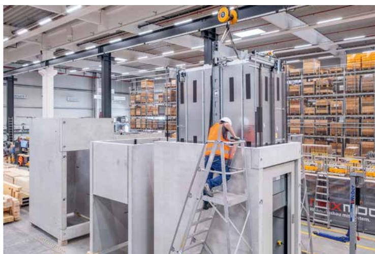
Aufzug in Modulbauweise: Der Fahrkorb wird im Werk des Bauunternehmens Max Bögl in ein Schachtmodul eingesetzt
