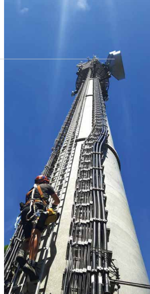
Bei der Inspektion eines Mobilfunkturms
