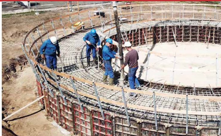
Bei Tief- und Betonbauarbeiten
