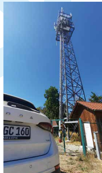
Standortabnahmen zählen zum festen Leistungsspektrum von GIMBEL CONSULTING
