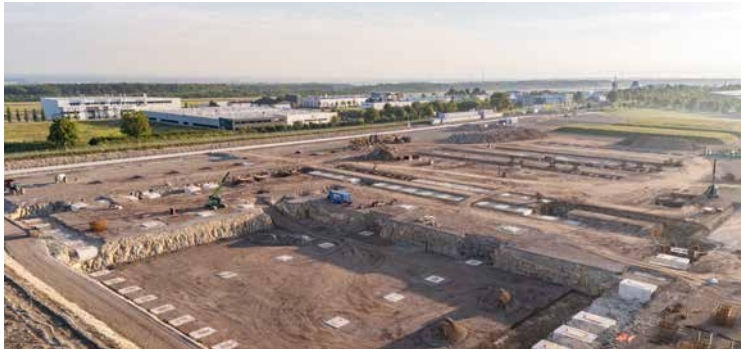
Großbaustelle aus der Vogelperspektive: Die Baubetrieb Finette GmbH ist deutschlandweit im Industrie- und Gewerbebau aktiv
