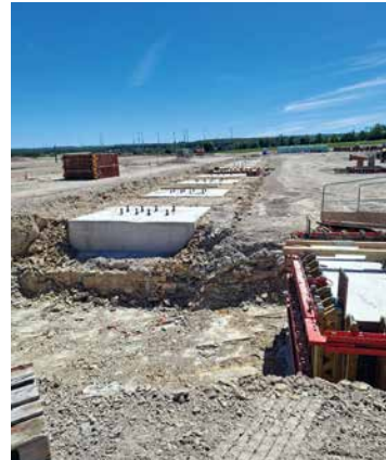
Blockfundamente auf der Großbaustelle
