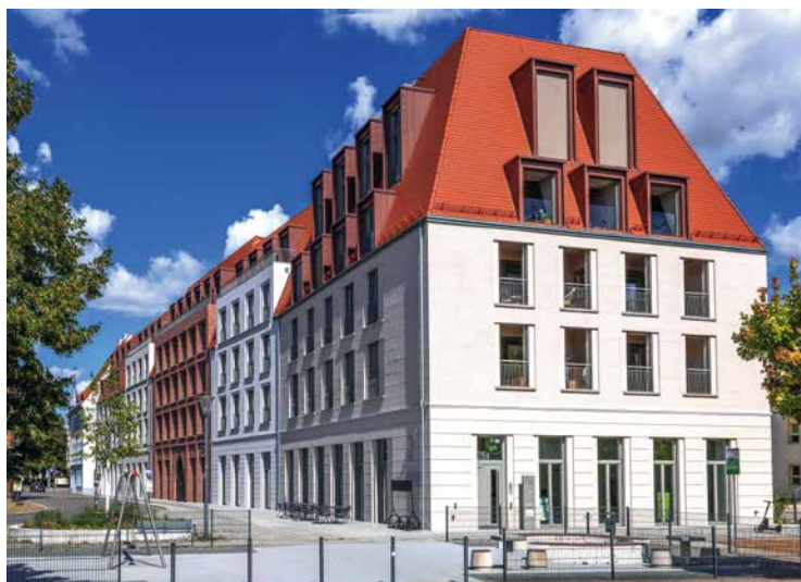
Neubau Wohn- und Geschäftshaus „Marienkirchblick“ der Wohnungswirtschaft Frankfurt (Oder)
