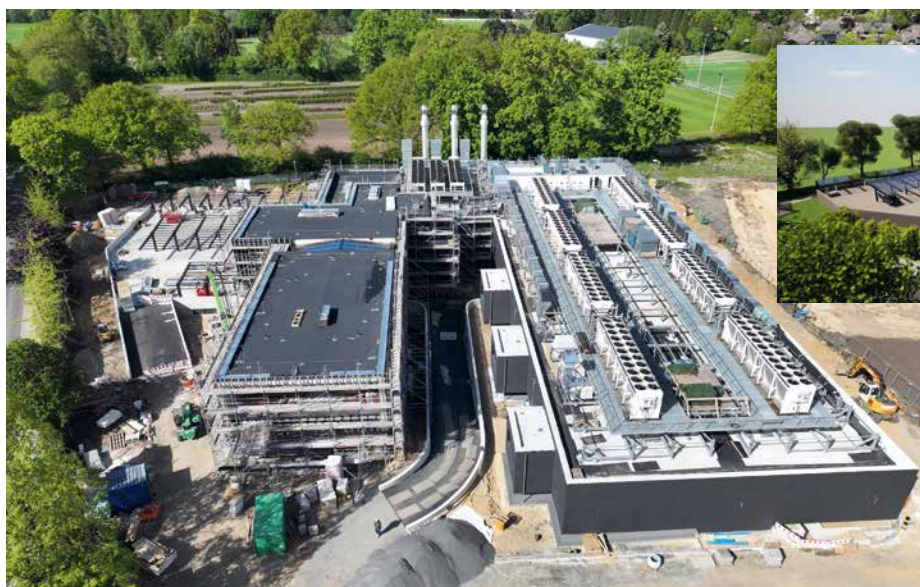
Neue Strukturen: Firmensitz mit Parkdeck mit Solarvorbereitung (l), Verwaltung (M.) sowie Technikriegel (hinten und r); Rechenzentrum dataR: Verwaltung (vorne), Technikriegel (hinten)
