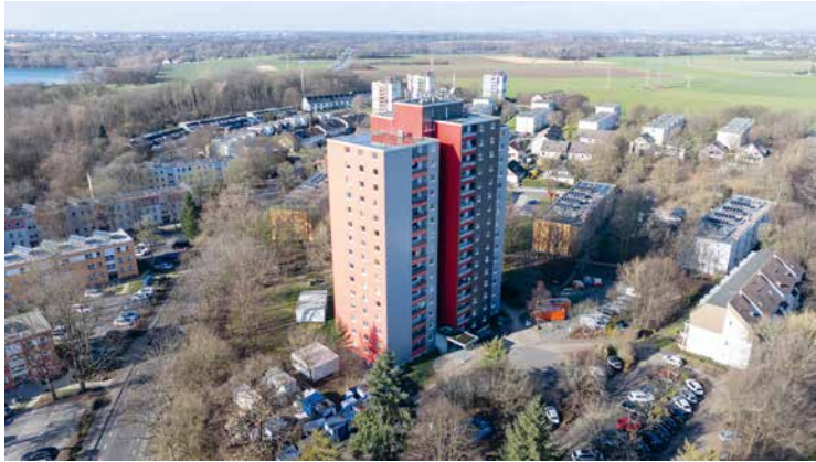
In Leverkusen sanierte Blome ein bewohntes Hochhaus – 14 Etagen mit jeweils sechs Wohnungen in nur drei Wochen – und lieferte eine Woche früher als geplant
