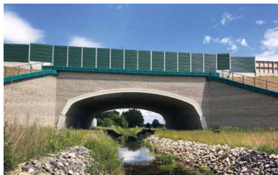
ConSpan bietet als Betonbauweise eine Alternative zur Wellstahl-lösung
