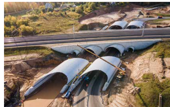
ViaPlate 380 trägt eine Bahntrasse – montiert ohne Betriebsunterbrechung
