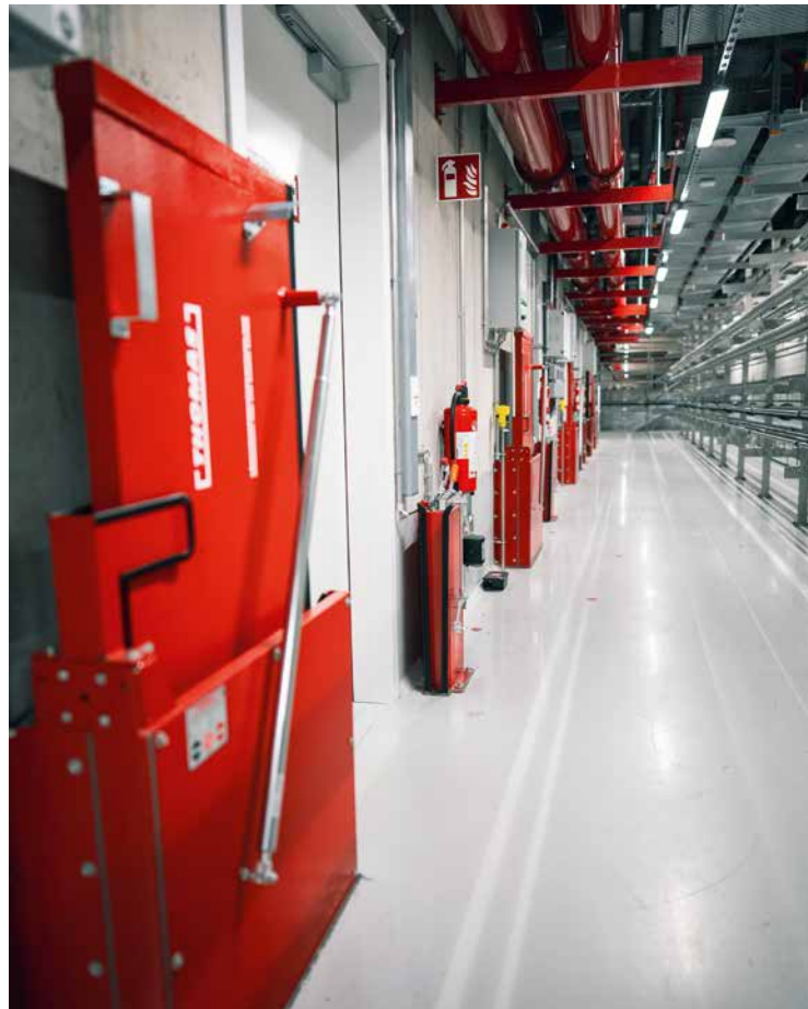
THOMAS Löschwasserbarrieren: Die markante rote Oberfläche steht für geprüfte Sicherheit – entwickelt, um kontaminiertes Löschwasser im Ernstfall zuverlässig zurückzuhalten
