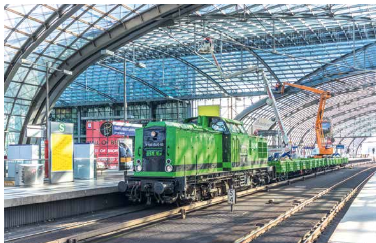
Am Berliner Hauptbahnhof modernisiert und erneuert BUG Verkehrsbau zentrale Teile der Schieneninfrastruktur und stärkt die Leistungsfähigkeit dieses wichtigen Verkehrsknotens
