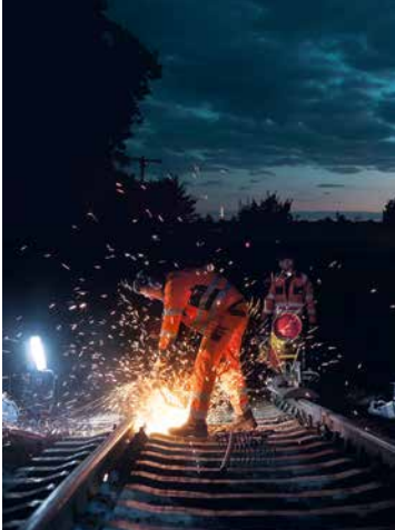
Nachtschweißarbeiten sichern Instandhaltung und Modernisierung der Fahrwege
