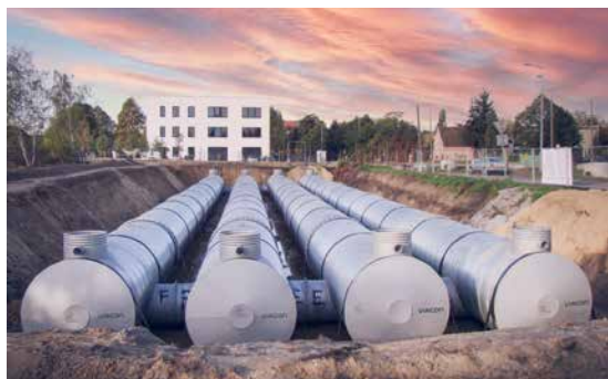
Eine Löschwassertankanlage aus Wellstahl zeigt die Vielseitigkeit des Produktportfolios
