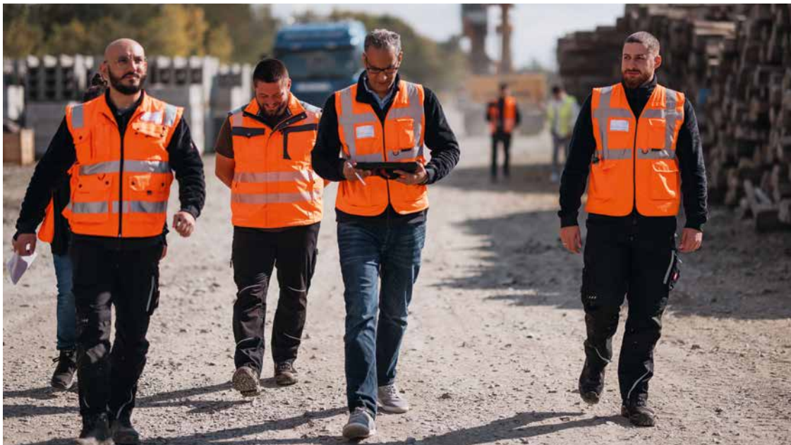
Vor Ort koordinieren Bauüberwacher die Umsetzung und sorgen dafür, dass die Abläufe auf der Baustelle reibungslos funktionieren
