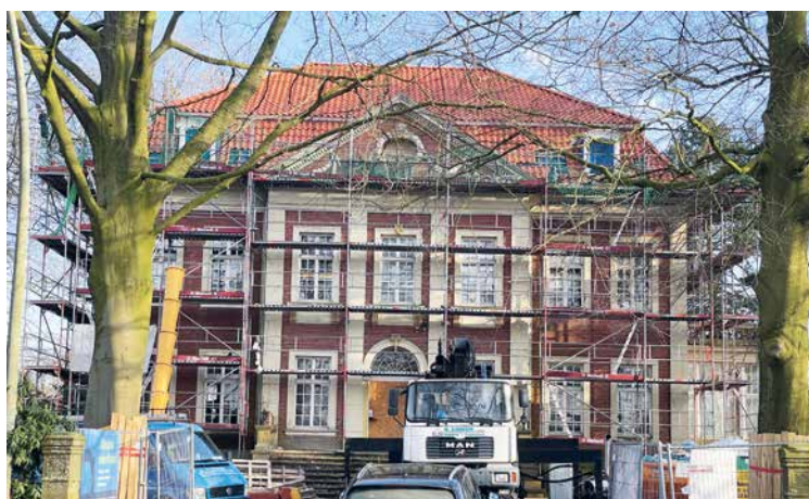
Energetische Sanierung im Bestand: die Villa Remy im Modernisierungsprozess
