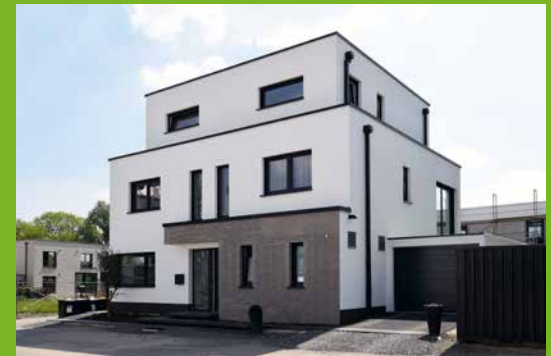
Wohnhaus in Duisburg-Angermund
