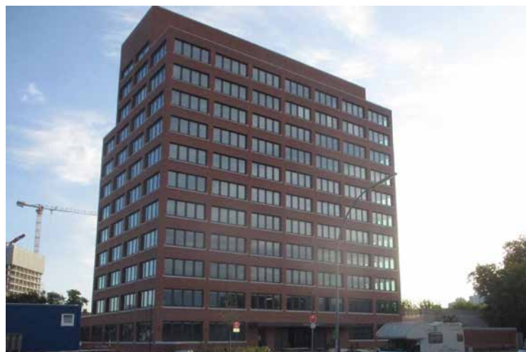
Neubauprojekt Neuköllnische Allee 9, Berlin: ITV plante die gesamte Gebäudetechnik für das moderne Gewerbegebäude mit rund 13.000 m 2 Bürofläche
