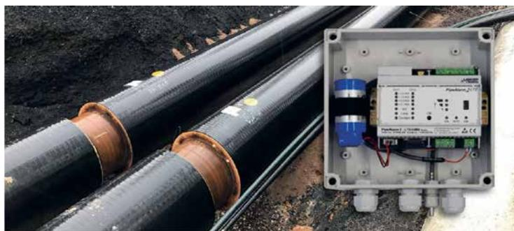
Mit dem Fernwärmerohr-Überwachungssystem PipeMonitor lassen sich frühzeitig Leckagen erkennen – für einen störungsfreien Betrieb
