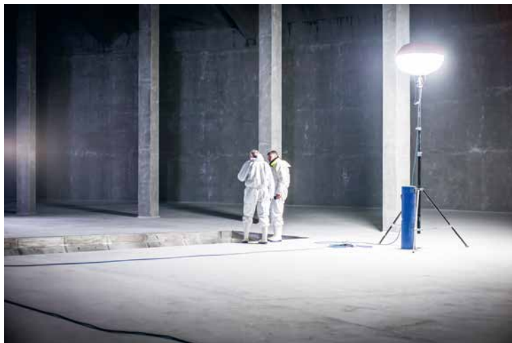
Frisch instandgesetzter Trinkwasserbehälter kurz vor der Wiedereinbetriebnahme – höchste Hygienestandards für eine sichere Wasserversorgung
