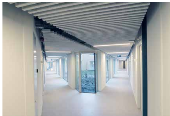
Die Installation von Videoüberwachungs- oder Brandmeldelanlagen...
