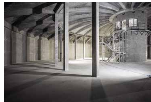
Sanierung eines Trinkwasserbehälters: sorgfältige Arbeiten sichern die Qualität der Wasserversorgung
