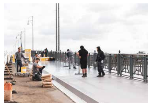
Beschichtungsarbeiten an der Theodor-Heuss-Brücke in Mainz: nachhaltiger Korrosionsschutz für eines der wichtigsten Rheinbauwerke
