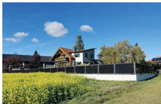
Ein Solarzaun aus bifazialen (von beiden Seiten nutzbaren) Modulen liefert nicht nur einen hohen Ertrag, sondern ist auch ein Blickfang
