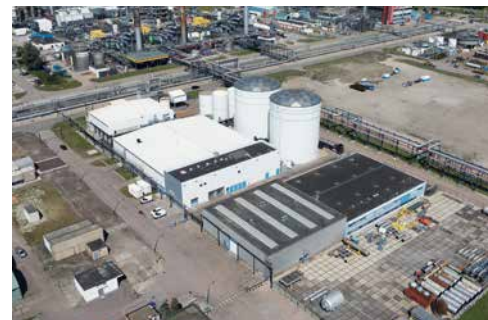
Zentrale VE-Wasseraufbereitungsanlage im Rotterdamer Hafen
