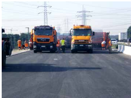
Fahrbahndeckenerneuerung auf der Autobahn A6 bei Mannheim
