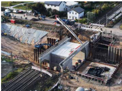
Neubau Eisenbahnüberführung Fahrweg bei Worms
