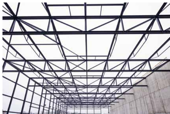
Dachkonstruktion aus Green Steel – dem umweltfreundlichen Stahl gehört die Zukunft
