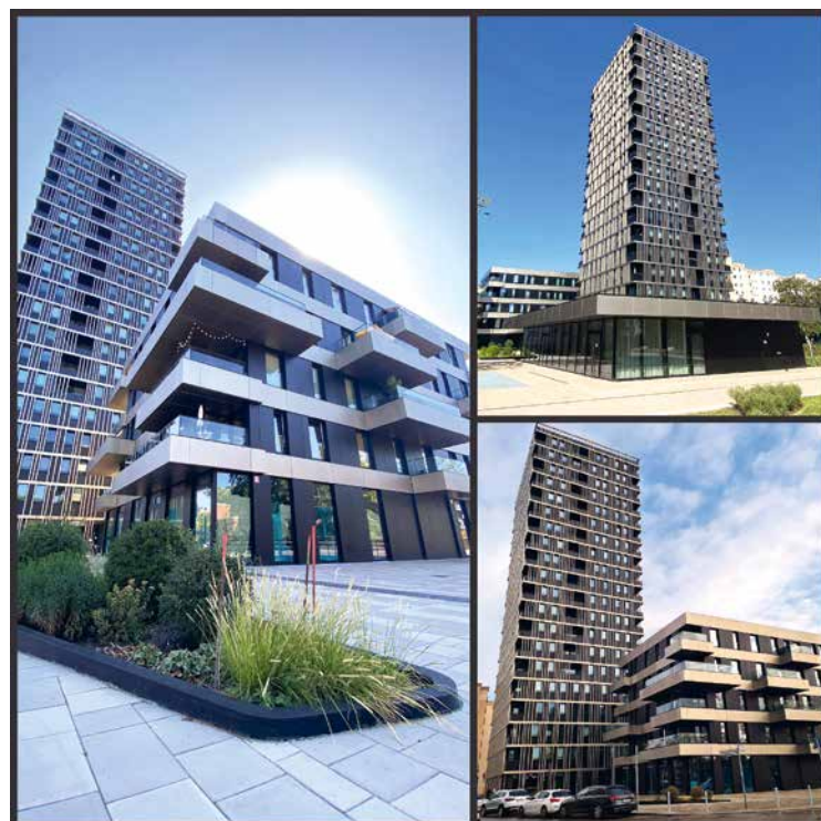
Das Ingenieurbüro Rüdiger Jockwer sorgt dafür, dass bei Neubauten die Statik stimmt, wenn es hoch hinaus geht
