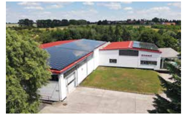
In Werk 2 befindet sich neben Zuschnitt und Kaschierung die PUR-Fertigung mit zwei Hochdruck-Schäumenanlagen
