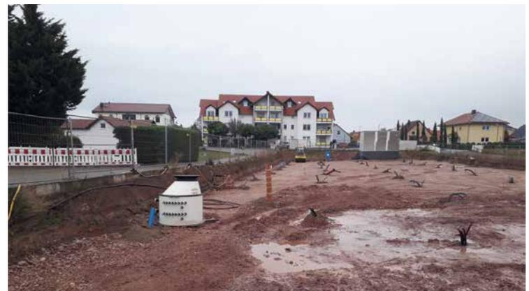
Das Erdsondenfeld im Neubaugebiet Gensingen; hier wurden 72 Erdbohrungen à 200 m für Sole-Wasser-Wärmepumpen in den Häusern abgeteuft
