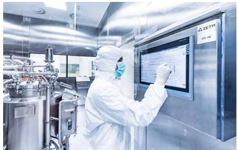
Vollautomatisiert: die Pharma-Produktionsanlage von ZETA
