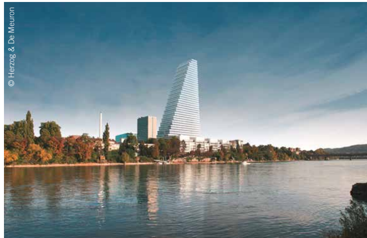
Das Forschungs- und Entwicklungszentrum Roche in Basel ist nicht nur was seine Höhe angeht ein Superlativ, sondern auch äußerst energieeffizient
