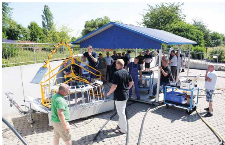
Learning by Doing: Praktischer Teil eines Seminars zum Verlegen von Glasfaserkabeln
